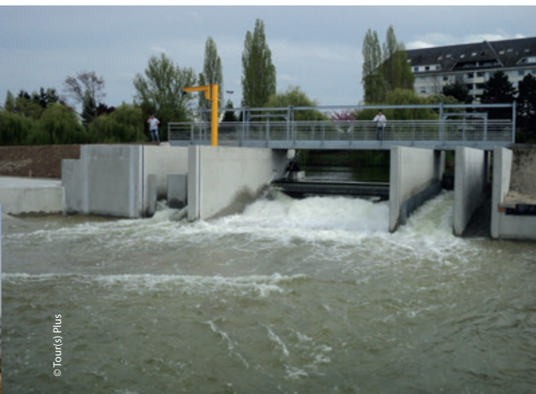
L'ouvrage de prise d'eau avec les passes à poissons, vu depuis le bassin de départ.
