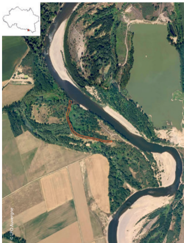
Vue aérienne de la boucle du Buisson et localisation de l'enrochement.
