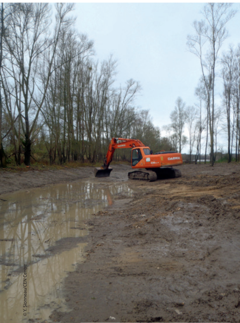
Restauration d'une frayère à brochets à Bertignolles (37).
