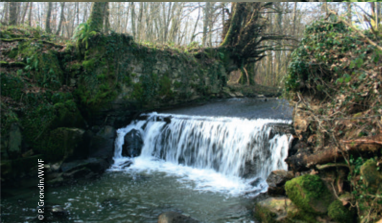
Seuil moulin Canne : Les ouvrages sont nombreux sur le bassin. Ici le seuil d'un moulin sur la Canne.
